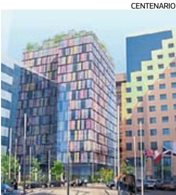
La construcción de 14 pisos busca la certificación LEED.
