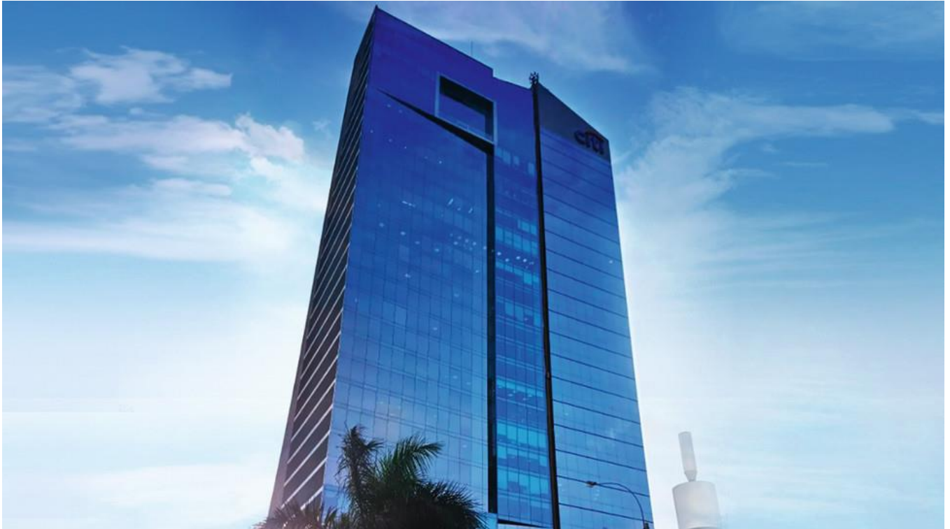
Torre Barlovento (C&J Constructores). Un proyecto Green Building de oficinas prime que refleja un compromiso con el desarrollo de la sociedad, la economía y el cuidado del medio ambiente.
